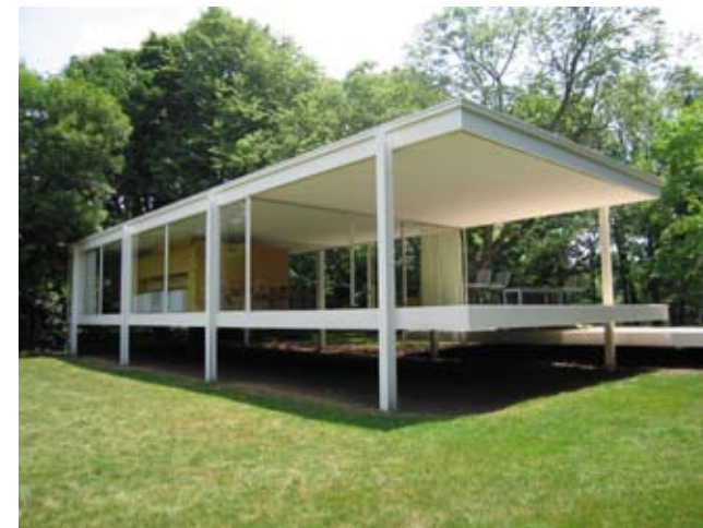
Mies van der Rohe. Farnsworth house (1946-51), Plano, Illinois. Gardinerna som ses täcka delar av glasväggarna gjordes motvilligt av Mies efter många dispyter med ägaren, Edith Farnsworth. Ursprungligen var vegetationen runt huset vild.
