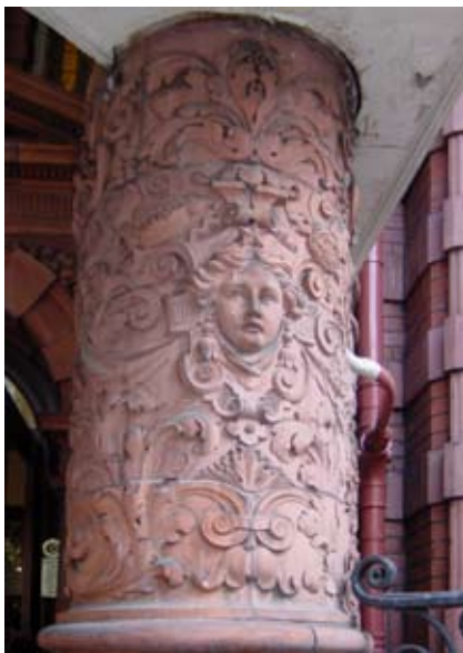
Ornamentering på pelare. The Metropole Hotel, King Street, Leeds, 1800-tal.
