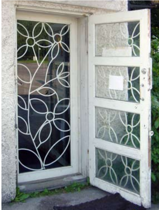
Dörr till reparations- och serviceverkstad för video, Esbo. Bilden tagen 2001.
