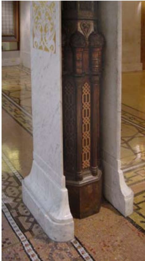
Burnham & Root. The Rookery , 1888. Lobbyen renoverades av Frank Lloyd Wright 1907. Han tillförde bl.a. ornamenteringen i vit marmor med förgyllda avsnitt. Intressant är att Wright klädde in de mörka ornamenterade stolparna av gjutjärn med vit ornamenterad marmor för att skapa ett ljusst uttryck.
