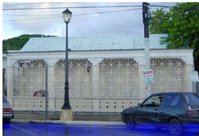
Ornamentering som en del av konstruktionen. Skyddsgaller mot inbrott. Vieques, Puerto Rico. Bilden tagen 2002.
