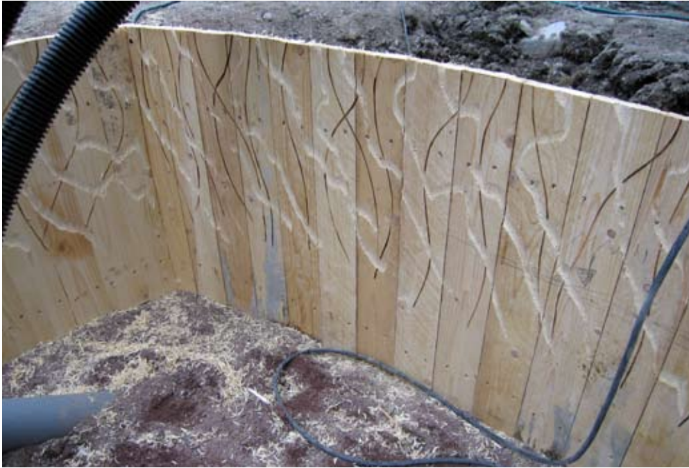
Ornamentiken för sockeln på lagerbygganden gjordes mera expressivt; med vinkelslipmaskin och motorsåg. 2006.
