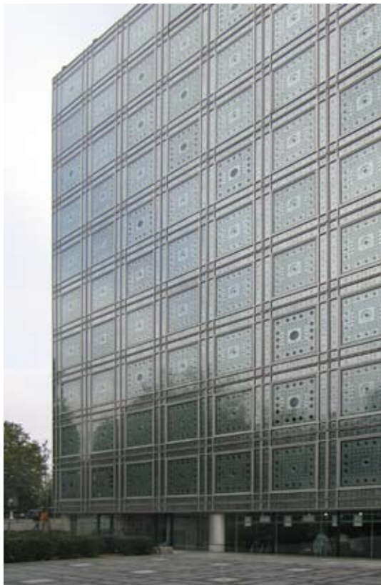
Mekanisk konstruktion som ornament. Jean Nouvel. Institut du Monde Arabe, Paris, 1987.
