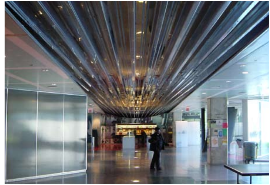
Röret som innesluter "L" tågbanan, ses som tak i campusbyggnadens caféteria.
