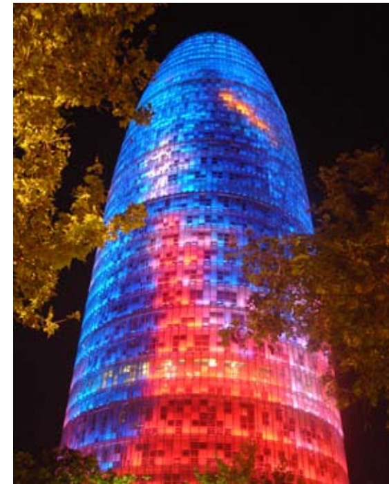
Mekanisk konstruktion som ornament. Jean Nouvel, Torre Agbar, Barcelona, 2005.
