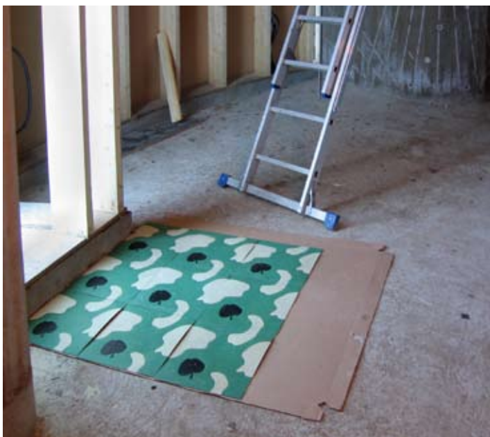
Provsurna ornamenterade plattor (mönstret Apple, Grass and Snow) av linoleum för vardagsrumsgolvet. 2007.
