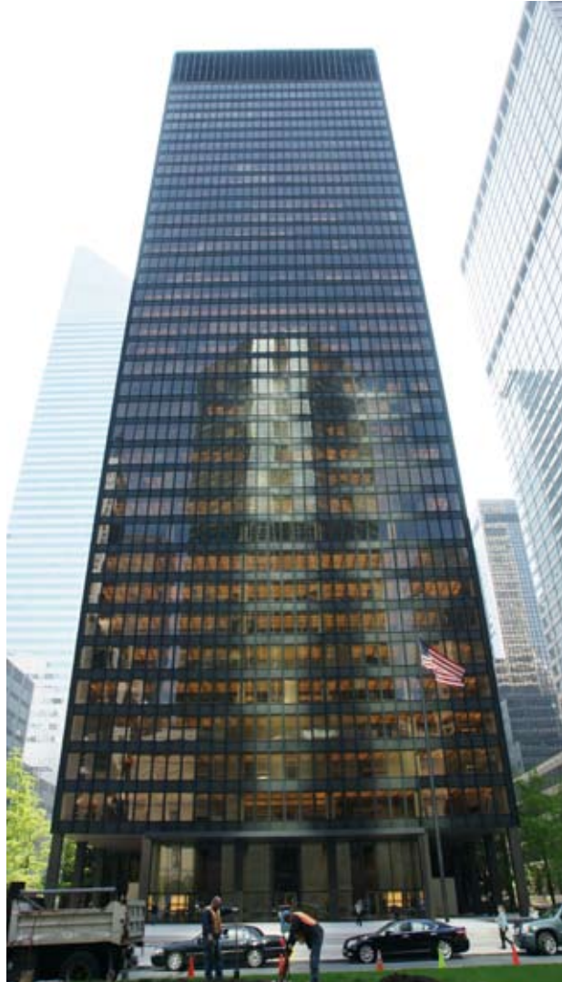
Ornamentering med hjälp av icke funktionella I-balkar. Mies van der Rohe, Seagram building , New York, 1957. Bild: Wikimedia Commons.
