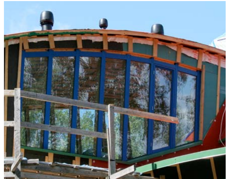
Datorstudion (i halvfärdigt skick) med ventilationspipor. Fönsterprofilernas färg och struktur är ämnade att påminna om färjan i Brasilien på bilden intill. Bilden tagen 30.7.2008.
