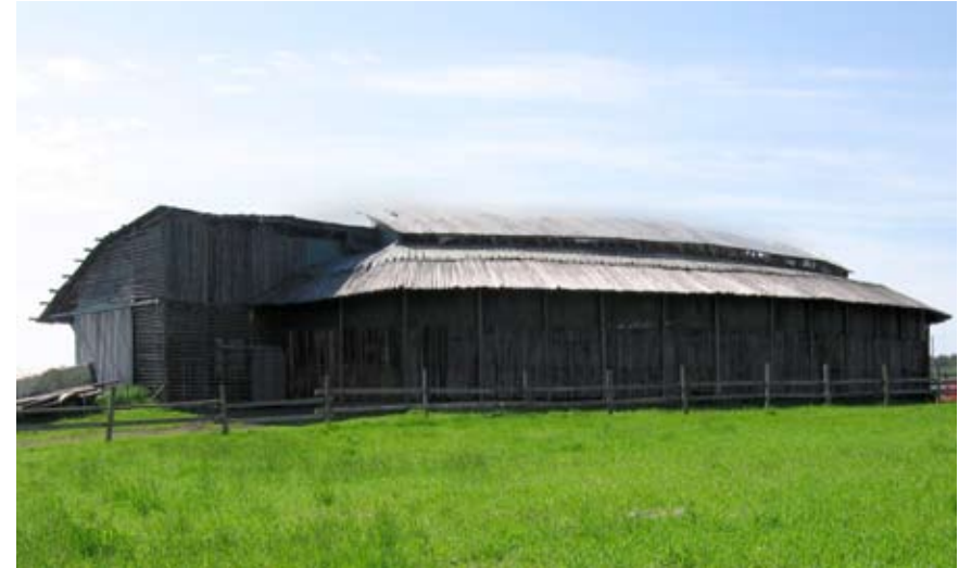
Rosegarden (Jan-Erik Andersson och Erkki Pitkäranta). Kummin - den ekologiska ladugården . 1997. Fasaden är gjord av det rundade virke som blir över när man gör plankor av trädstammar.
